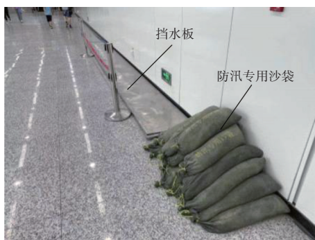
图1 地铁防汛专用沙袋及挡水板
