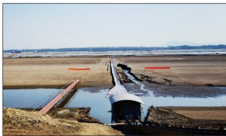
图9 武穴市龙坪镇水厂新架管道
